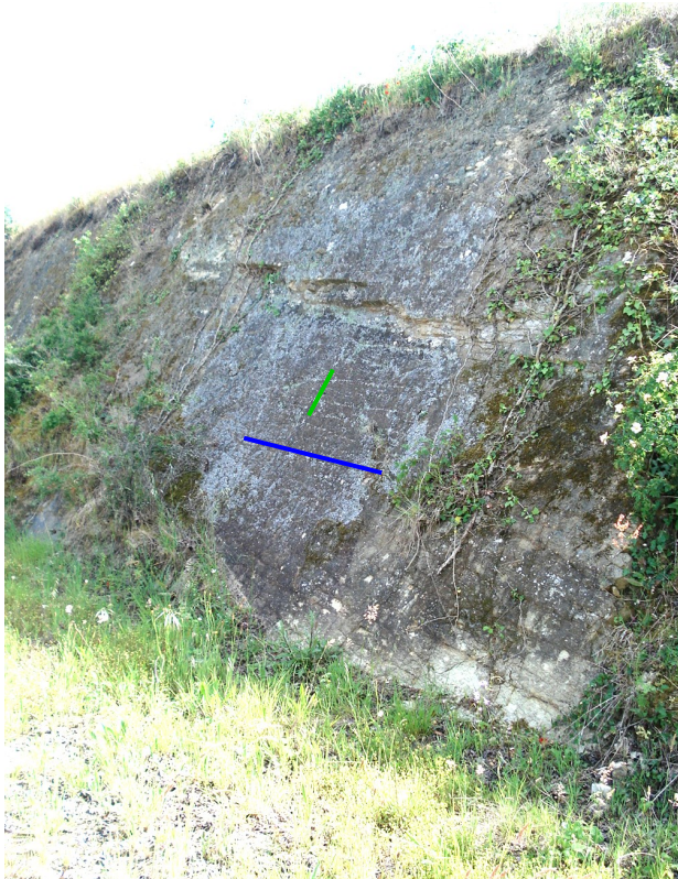
Les deux autres grandes directions de clivage visibles sur le plan de la stratification et qui lui sont perpendiculaires : les traces en bleu parallèles au sol de la tranchée et les traces en vert perpendiculaires au sol
